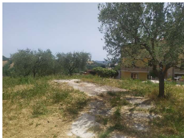
Piattaforma in calcestruzzo
